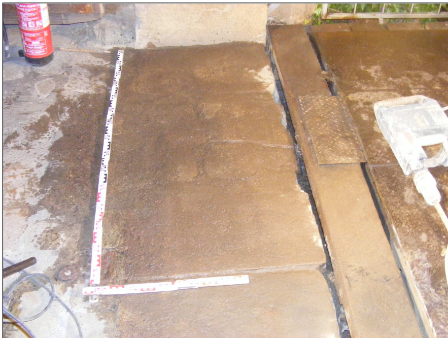
Vista del paviment un cop extreta la planxa metàl·lica
