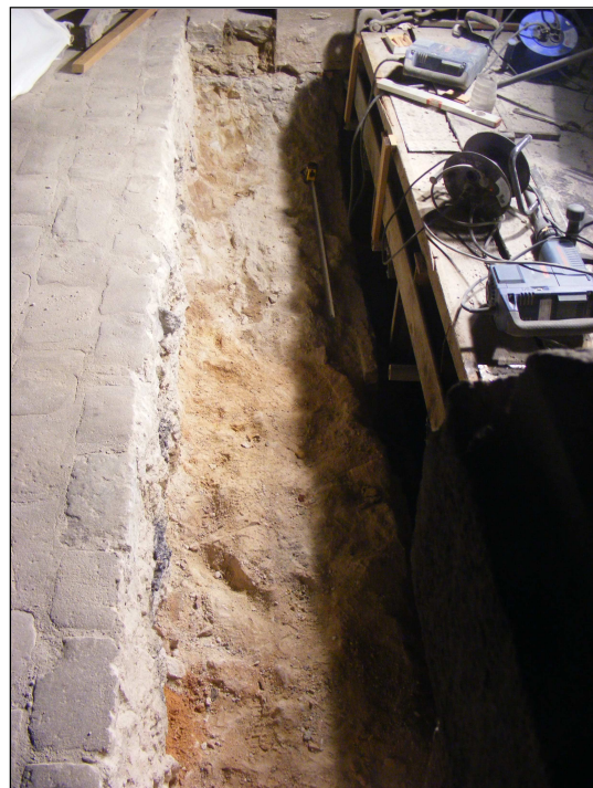
Vista final del rebaix de l'estrep del Pont
