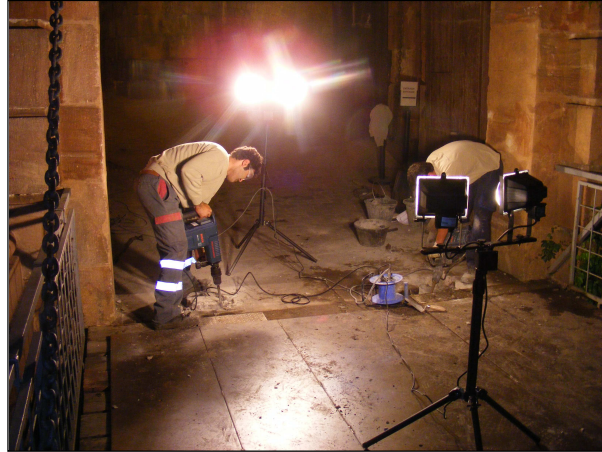
Vista del procés d'extracció del paviment del marxapeu UE 5200.
