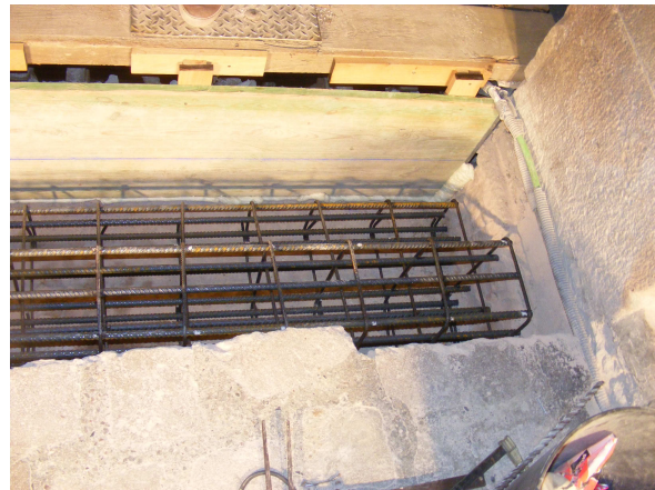
Detall de la nova estructura de sustentació
