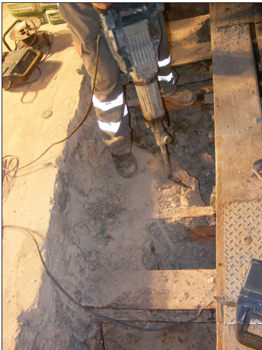
Vista inicial de la UE 5203
