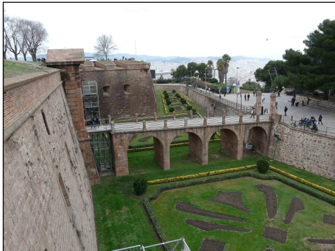
Vista general del pont amb la porta d'accés al castell. A la dreta la part fixa del pont, a l'esquerra el pont llevadís.
