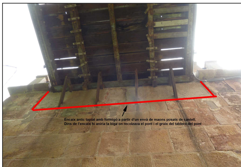
Detall de l'encaix posteriorment tapiat on recolzava el pont
