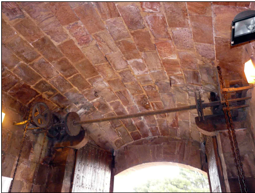
Detall de les restes del mecanisme que servia per pujar i baixar el pont llevadís.
