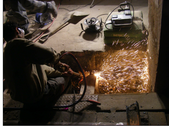
Procés d'afectació de les bigues de l'estructura UE 5203
