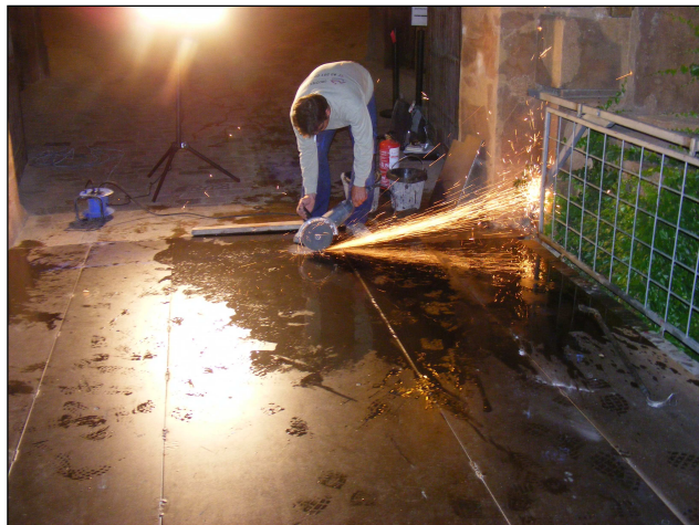
Vista general del procés de tallar les planxes metàl·liques a l'estrep del Castell
